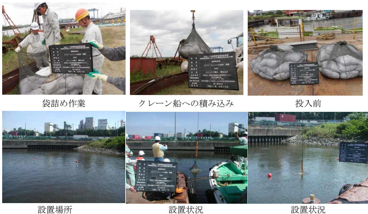
図 5-3-10 ユニットの再設置状況
